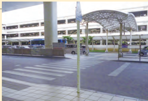
国内線エリア1F北側横断歩道出入口④付近
