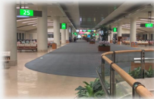
経年劣化したタイルカーペットの更新
